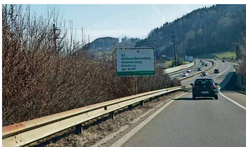
Vorwarnung: Schilder an der A3 weisen auf die geplanten Bauarbeiten hin. Bild Patrizia Pfister
